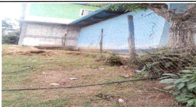
Foto 3: Reparación de tubo hg y malla galvanizada.
