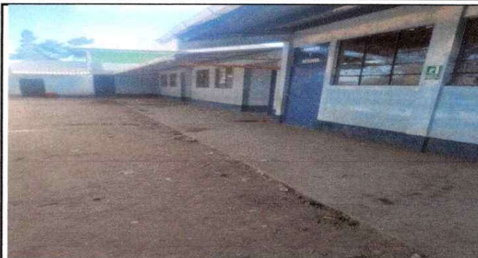
Foto 2: Pintura en muros exteriores e interiores.
