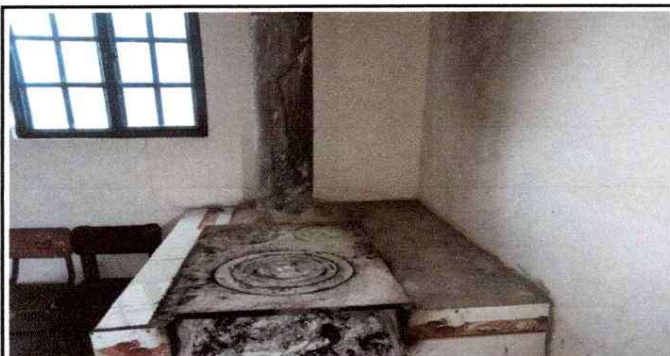
Foto 5: Sustitución de plancha de metal de 3 hornillas.
