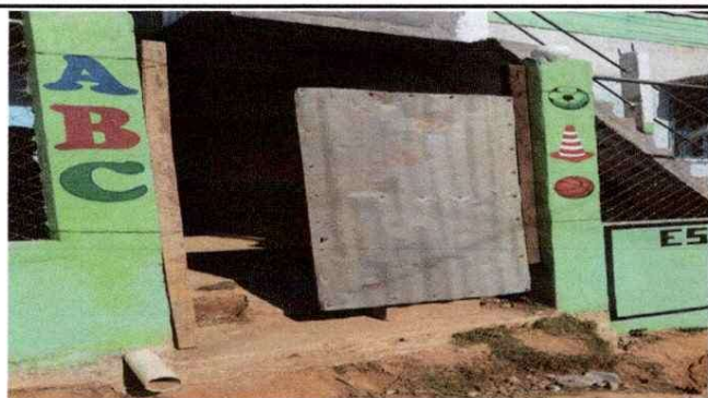
Foto 1: Sustitución de portón de metal.
